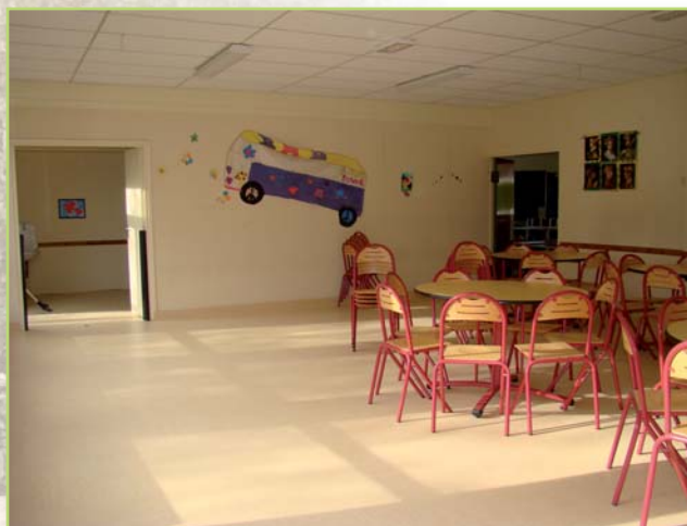
Nouveau revêtement des sols à la cantine
