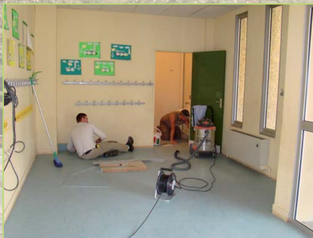
Travaux de réfection des sols à la cantine
