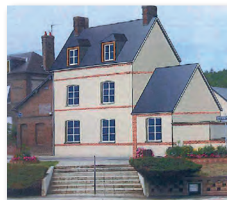
Maison Bach après restauration
