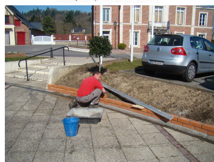
Pose de bordures sur la place de la mairie et fleurissement
