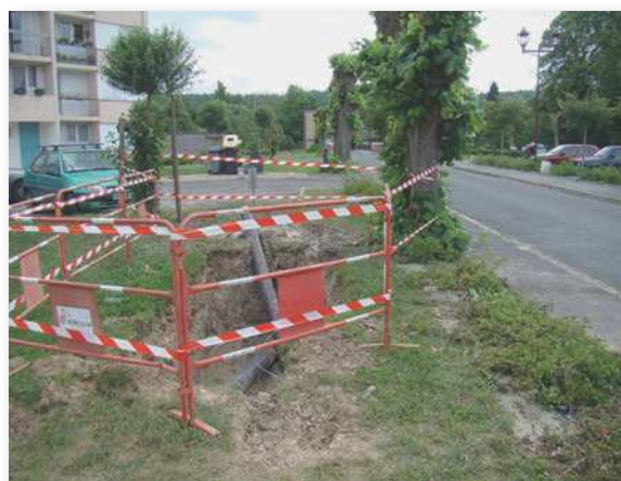
Passage de câble électrique par forage
