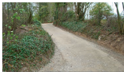
Réfection du chemin d'accès à l'ancienne décharge
