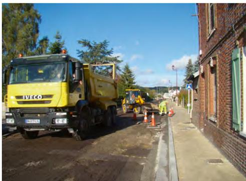
Après la réfection de la 1ère tranche de travaux en octobre 2016, la seconde tranche allant de la voie SNCF jusqu'à la RD 133 a été réalisée avec la réfection de la chaussée et des trottoirs, la pose de nouveaux coussins ralentisseurs, la mise en place de nouveaux lampadaires ainsi que les travaux d'enfouissement des lignes électriques.
