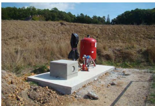
Afin de pouvoir arroser le terrain de football annexe, sans avoir à utiliser le réseau d'eau potable, des travaux de forage d'un puits d'une profondeur de 30 mètres et l'installation d'un système de pompage ont été réalisés pendant l'été 2019 sur le terrain annexe de football par l'entreprise Lecoq de Saint Clair d'Arcey. Cette installation opérationnelle en septembre a
