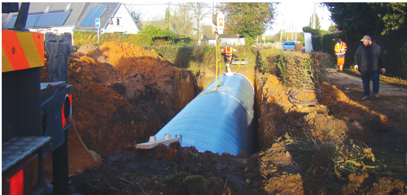
➔ Mise en place de la citerne enterrée au village La Porte
